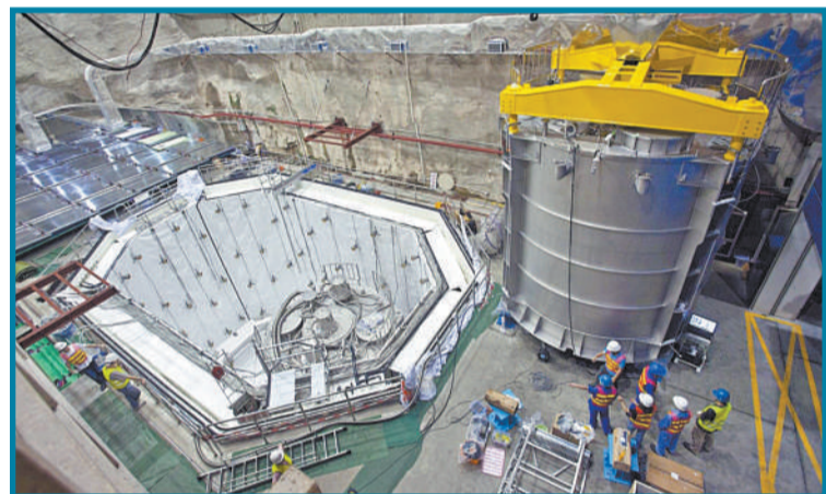
▲吊装中微子探测器入水池。
