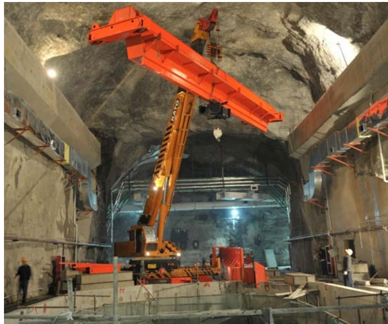
图 1#实验大厅桥机大梁安装
