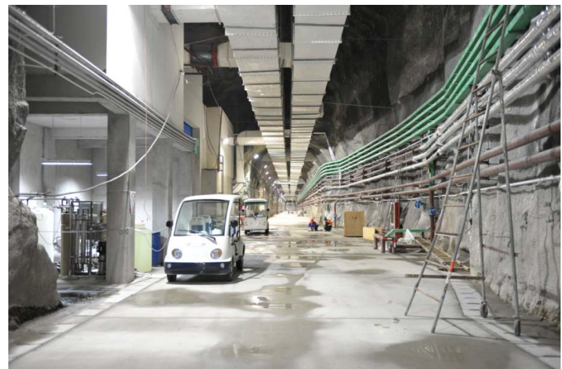
图片 5#厅外隧道
