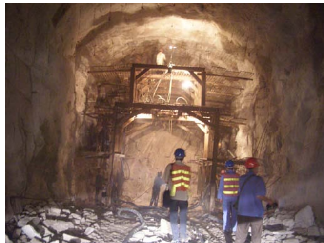
图 隧道塌方防护
