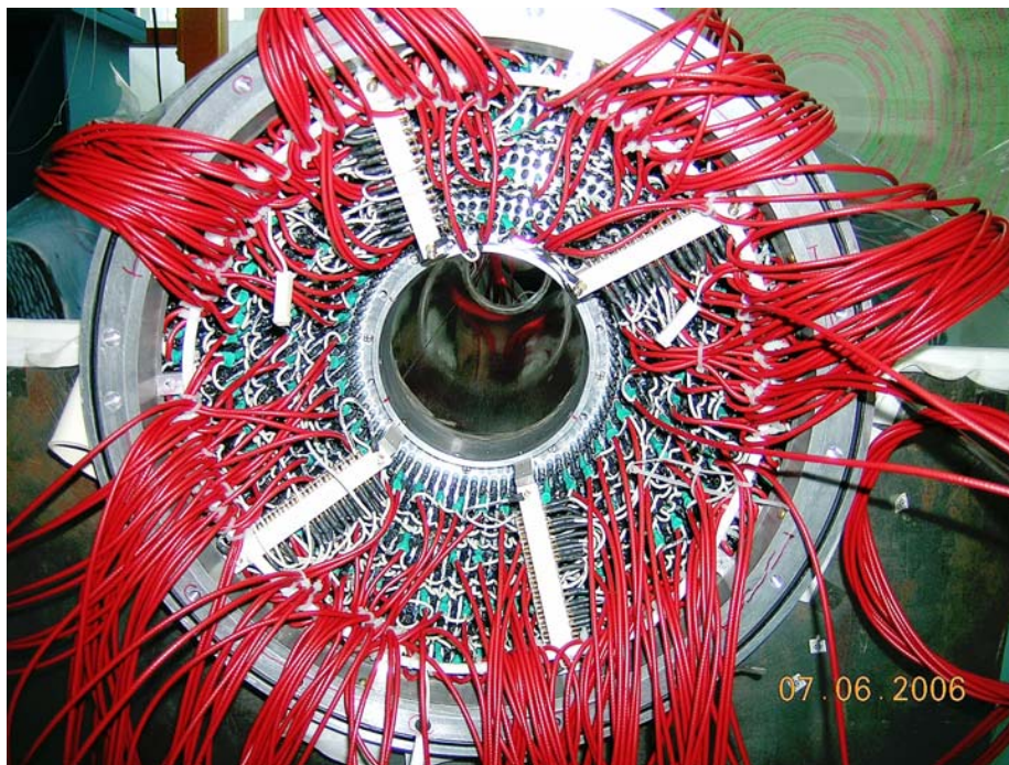
← 内室高压信号电缆的安装
